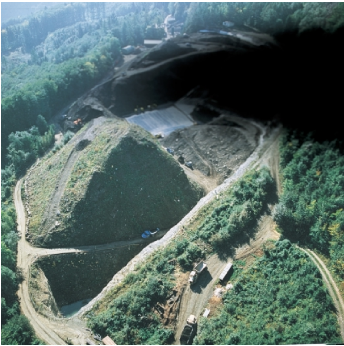
Gesamtansicht der Schlackendeponie Buchsberg SG mit Teilfläche Einbau Dichtungsbelag.
