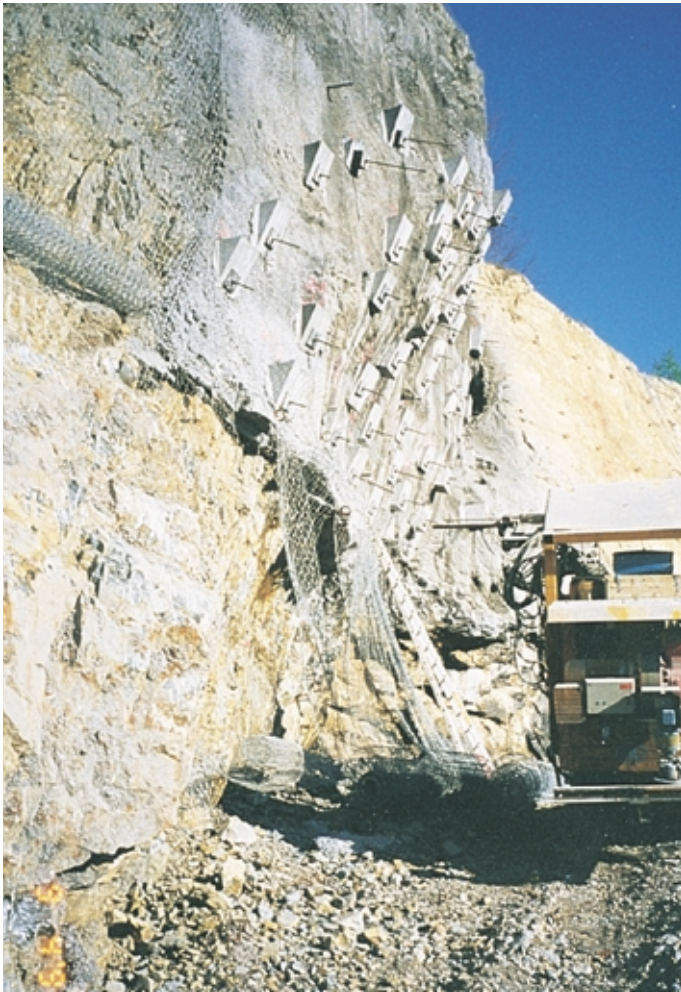
Absicherung der zum Teil überhängenden Felspartien
