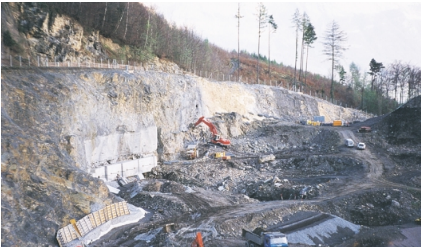
Umlagerung der Altlast, FEssicherung und Randabdichtung.
