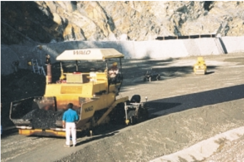
Einbau der mineralischen Abdichtung (rechts) und der Bindeschicht (links)
