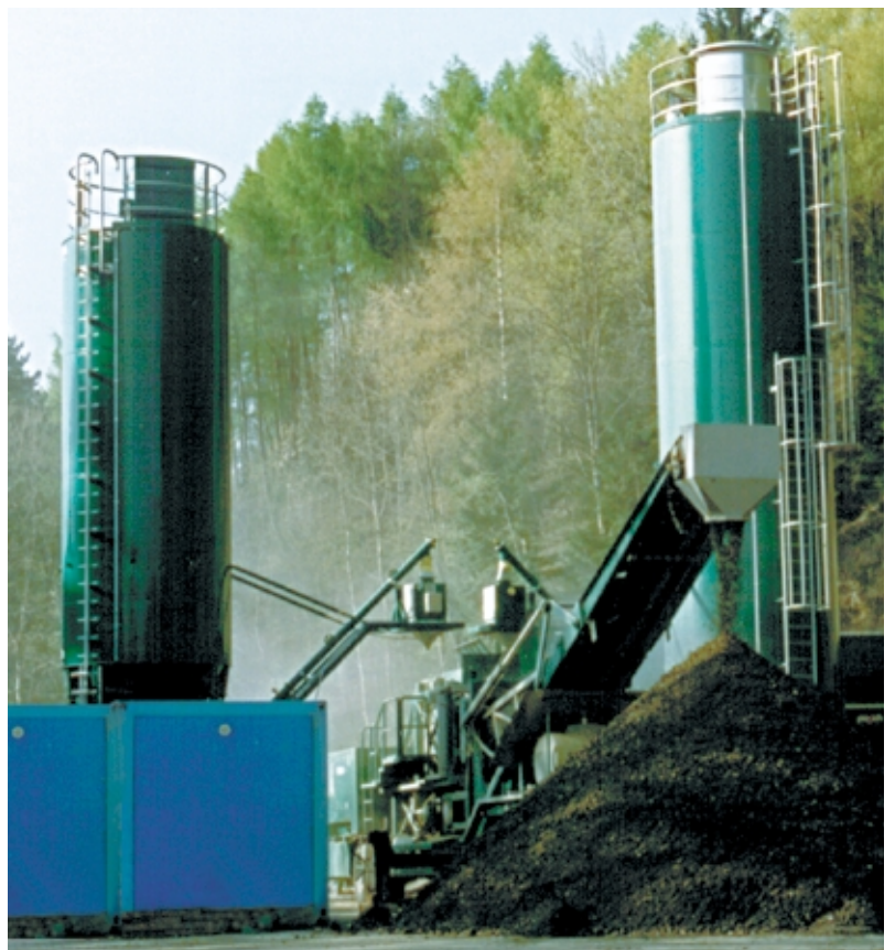
Mischanlage für mineralische Abdichtung und Sickerbeton.
